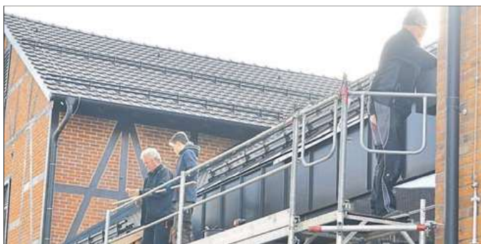
Letzte Arbeiten wurden in der vergangenen Woche am Dach über dem Eingangsbereich ausgeführt. Fotos: Walter Kreuzer
