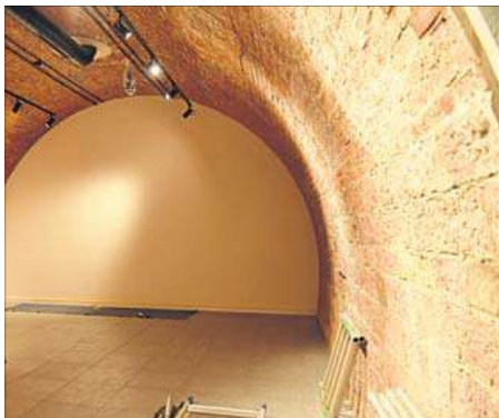
Der Kiez Keller besticht durch sein historisches Tonnengewölbe.
