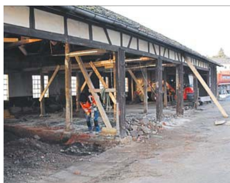
In der entstehenden Gastronomie wird gewerkelt.
