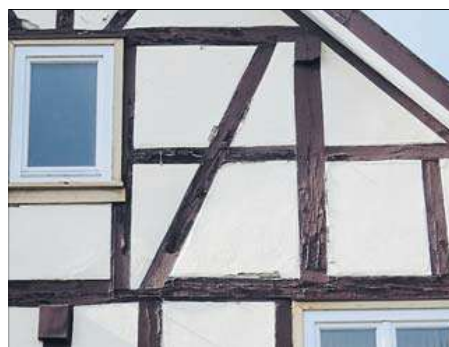
Fachwerkwohnhaus in einem Stadtteil: Dach- und Fassaden-sanierungen gehören zu den sehr häufig angefragten Baumaßnahmen. Das Förderprogramm der Dorfentwicklung kann hier unter anderem die erforderliche Sanierung von Fachwerkbalken und Gefachen bezuschussen.
