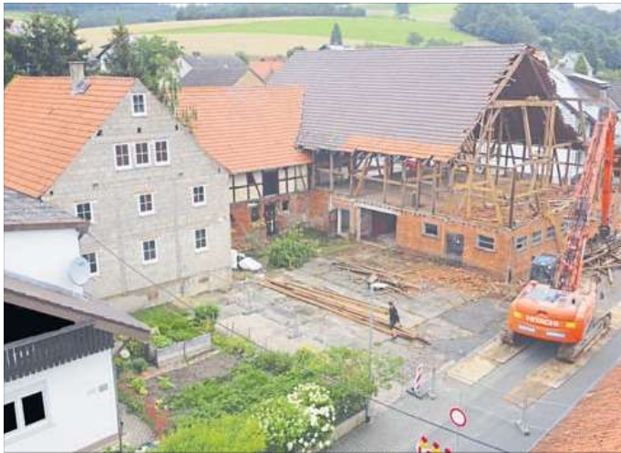
Die Abrissarbeiten aus der Vogelperspektive.
