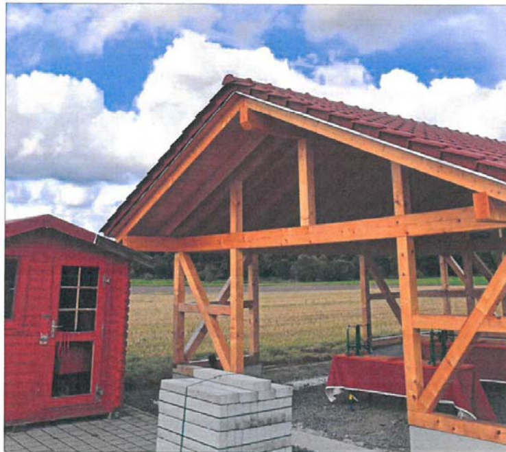
Auch in Hemmen entsteht eine lauschige Grillhütte.
