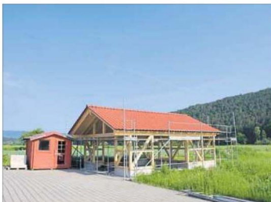
In Hemmen entsteht eine Begegnungshütte.
