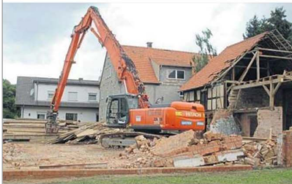
Die Abrissarbeiten sind im vollen Gange.
