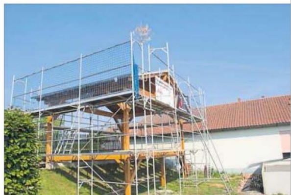
Auch beim Schützenhaus in Hartershausen wird eifrig gebaut.
