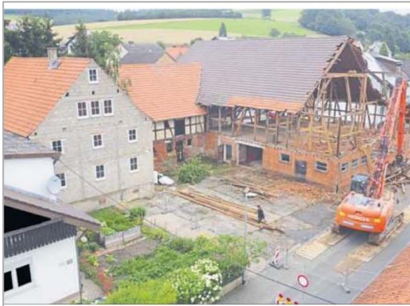
Die Abrissarbeiten aus der Vogelperspektive.
