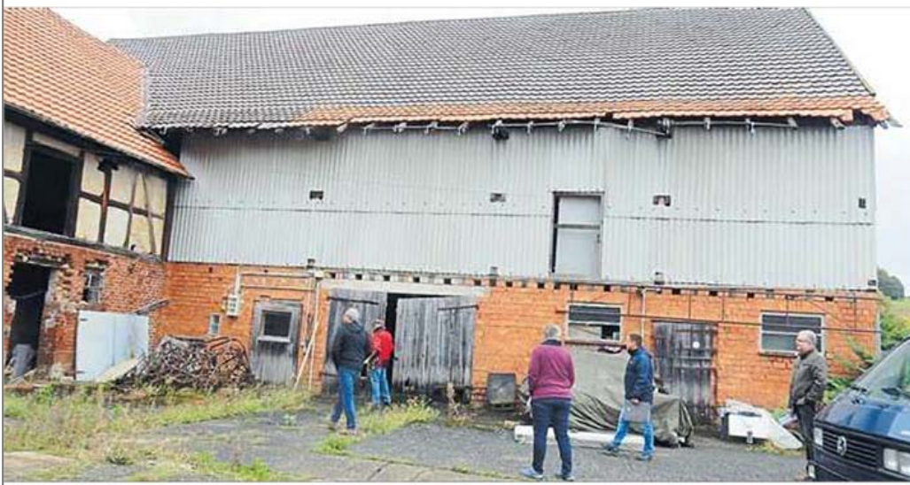
Ortsbegehung in Unter-Schwarz: gemeinsame Einschätzung der notwendigen Baumaßnahmen und der Bausubstanz mit den Aktiven vor Ort. Fotos: K.-D. Schnarr, plusConcept
