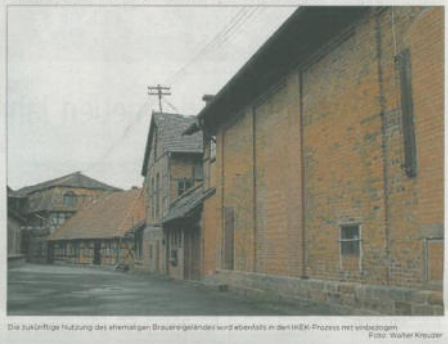
Die zukünftige Nutzung des ehemaligen Brauereigeländes wird ebenfalls in den IKEK-Forum mitberaten...
