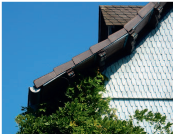
Ortgang mit besonderer Gestaltung im vorderen Odenwald
