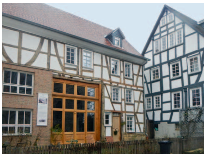
Umgebaute Scheune in der Wetterau
