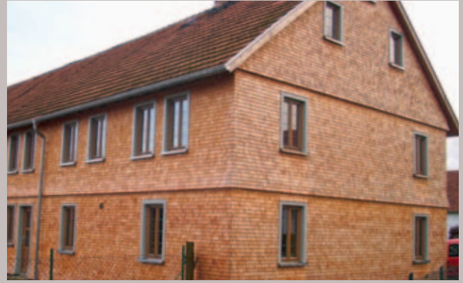
Lärchenholzschindeln an den Wetterseiten
