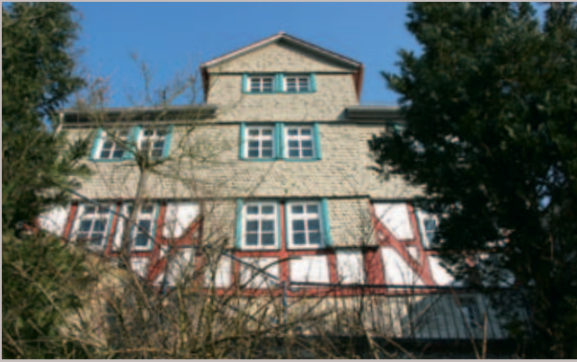
Beispiel einer Schindelverkleidung aus Nordhessen
