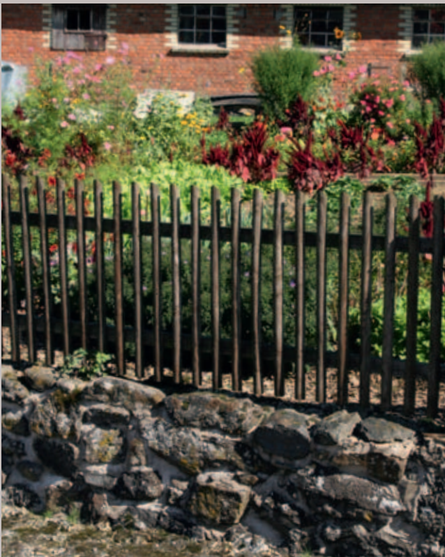
Lattenzaun auf Bruchsteinmauer
