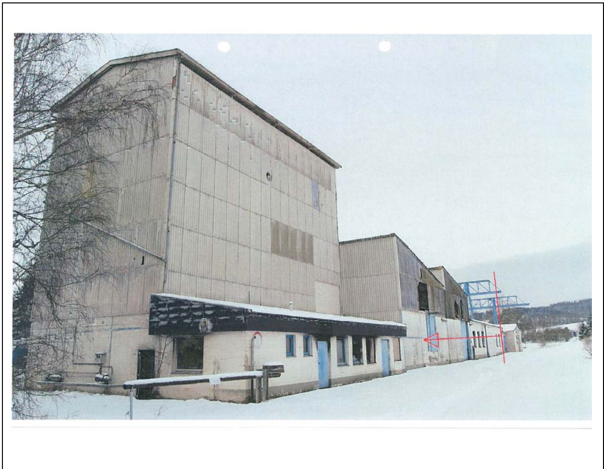
Abb. 6: Bisherige Gebäudekubaturen des ehemaligen Kalksandsteinwerkes)
