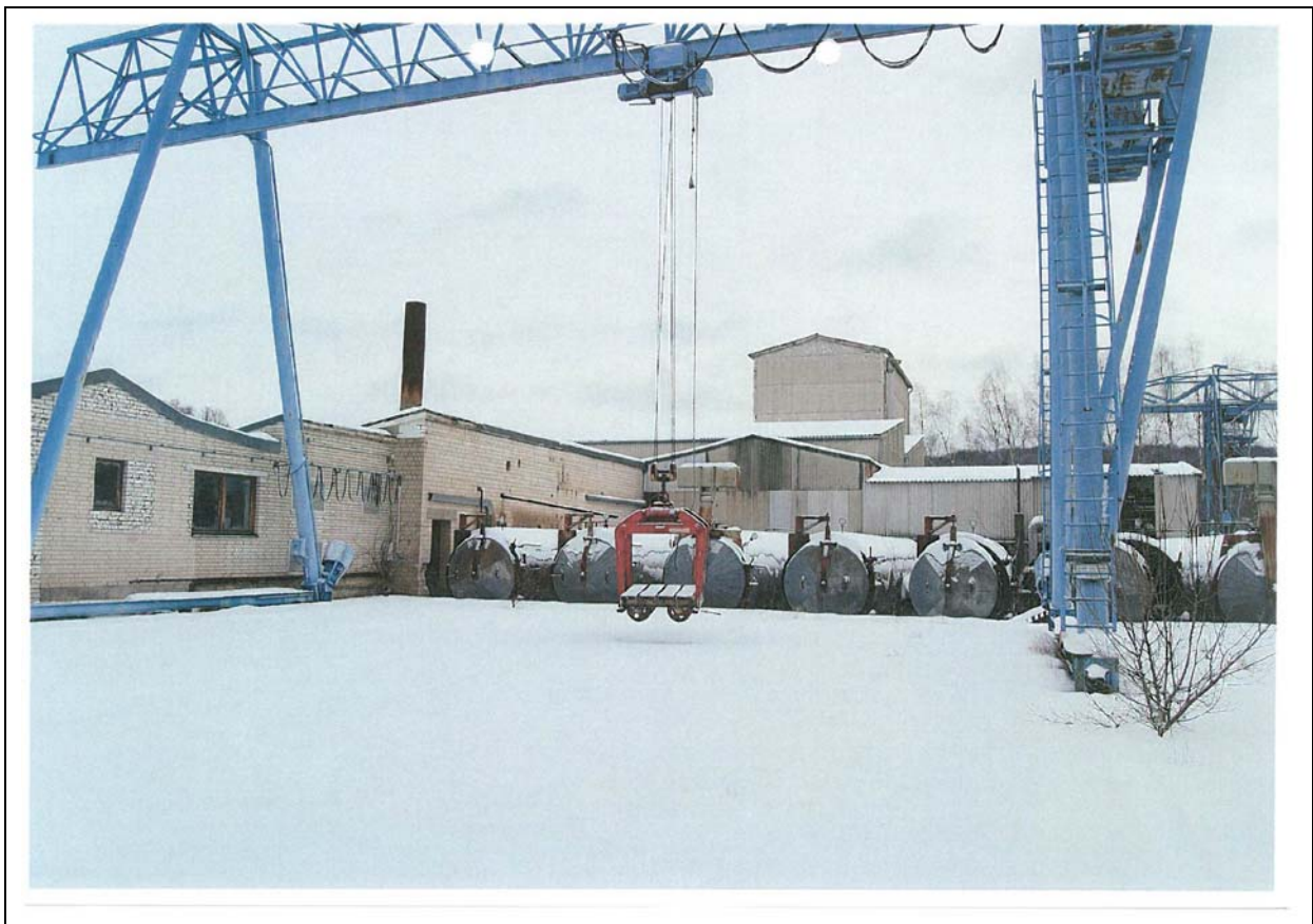
Abb. 7: Bisherige Gebäudekubaturen des ehemaligen Kalksandsteinwerkes)
