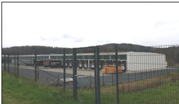
Abb. 5: Blick auf die bereits bestehende gewerbliche Bebauung im Westen des Plangebiets.
