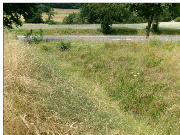
Abb. 15: Angelegter Graben am nördlichen Rand des Plangebietes.
